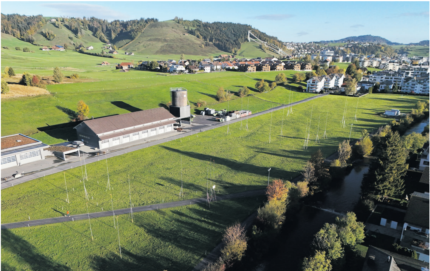
Der Stangenwald für das Sportzentrum Allmeind steht: Das Bauvorhaben liegt jetzt öffentlich auf.
