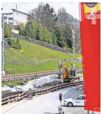
Der Bahnhof in Sattel wird verlegt.
